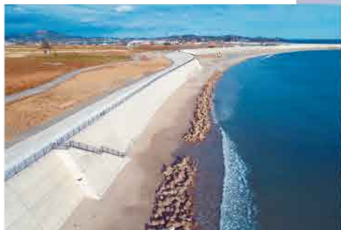
【林野庁宮城北部森林管理署】沖ノ田海岸第3治山工事 令和2年11月竣工
