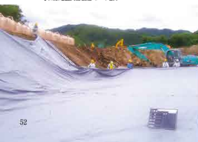
小川原地区災害復旧・シート張り
