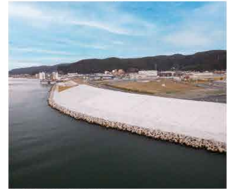
【国土交通省北上川下流河川事務所】 旧北上川左岸川口地区築堤 令和2年9月竣工
