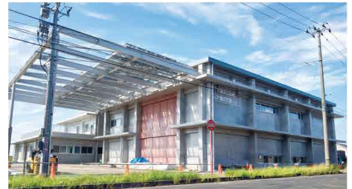
【宮城県名取市】名取市下増田公民館・下増田児童センター改築 令和5年8月竣工
