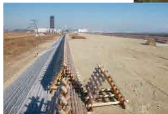
【林野庁仙台森林管理署】 仙台地区第十三治山工事 平成26年12月竣工
