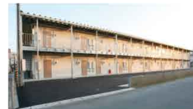
【宮城県土佐部】気仙沼地域南郷仮設職員寮 平成25年3月竣工
