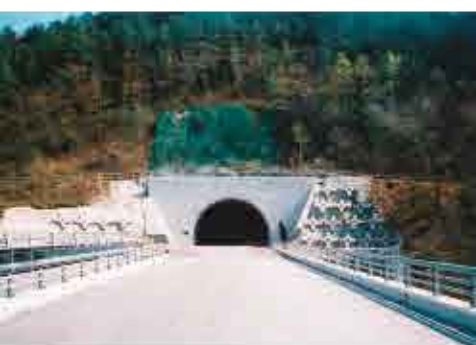
【宮城県】花洲山道路改良 平成13年1月竣工
