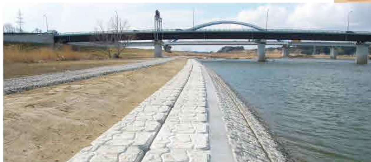
【国土交通省北上川下流河川事務所】吉田川鳴瀬管内右岸中流護岸補修 平成25年3月竣工
