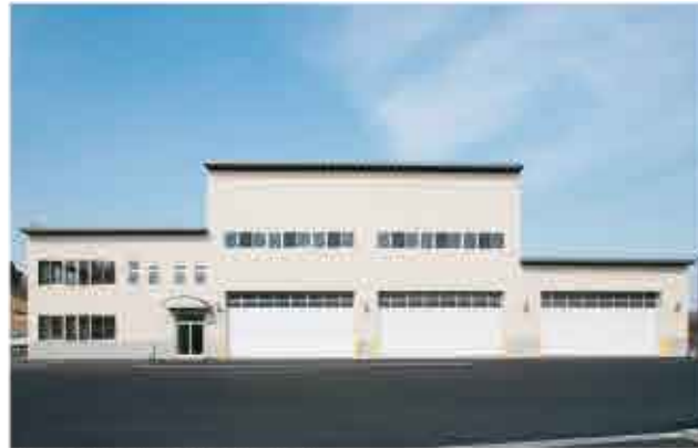
【国土交通省仙台河川国道事務所】 登米防災ステーション 平成29年2月竣工
