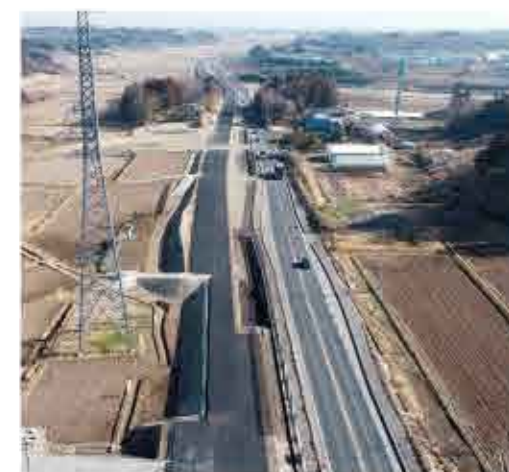
【国土交通省仙台湾河川国道事務所】 大衡北地区道路改良 令和5年3月竣工
