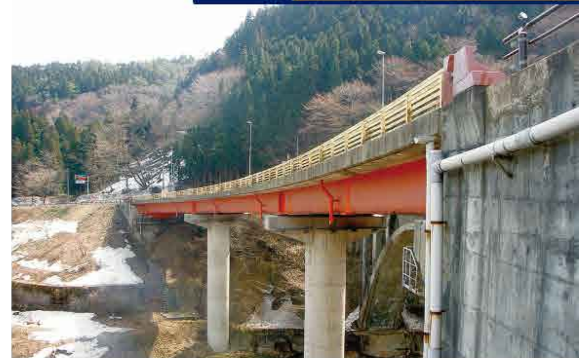
【国土交通省仙台河川国道事務所】鳴子管内橋梁補強 平成20年3月竣工
