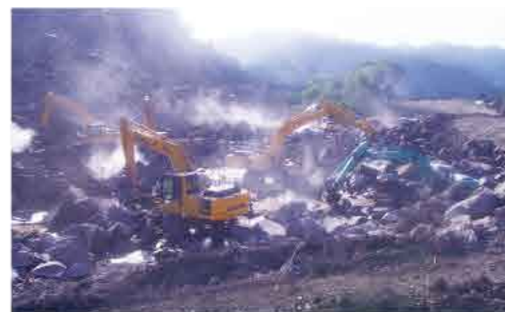
小川原地区災害復旧・土砂撤去
