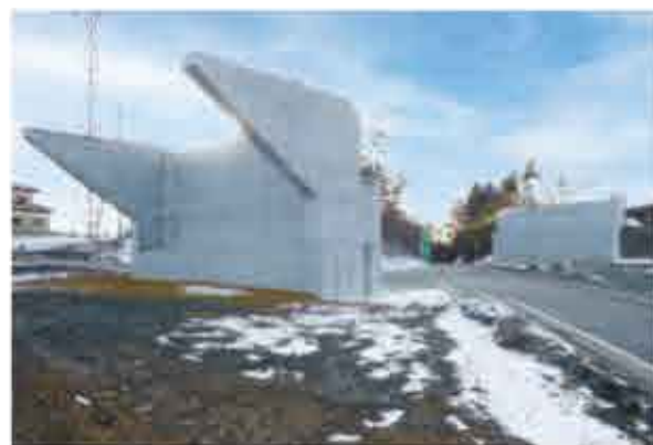
【国土交通省仙台河川国土地事務所】 沢尻橋下部工 平成25年2月竣工
