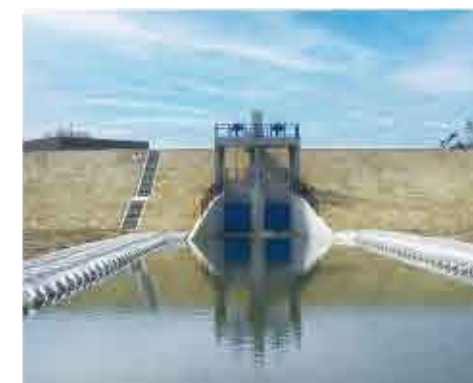
【国土交通省北上川下流河川事務所】 新江合川李坪排水機場樋門新設 平成20年7月竣工
