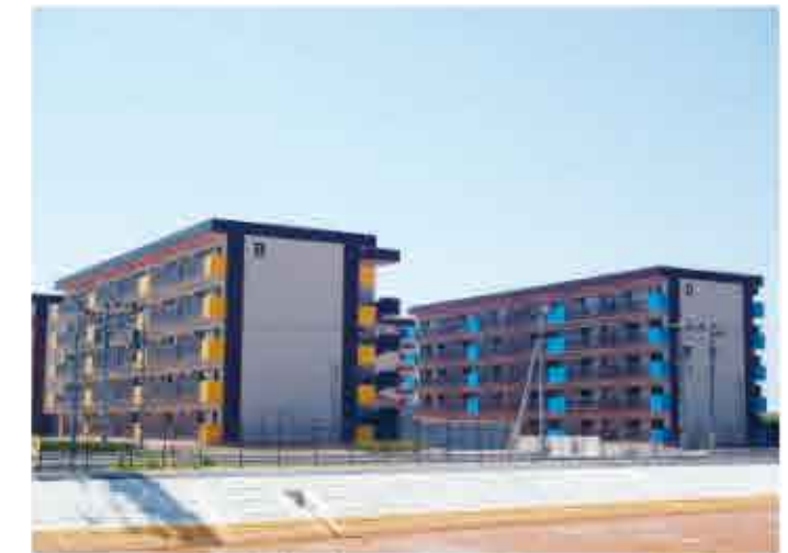
【宮城県土木部】石巻市新蛇田地区災害公営住宅 平成27年6月竣工
