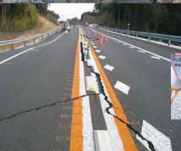
東日本大震災仙台北部道路 利府しらかし台IC～富谷JCT間復旧工事
