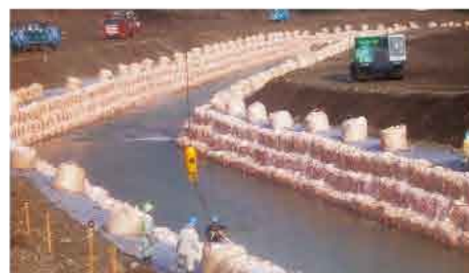
小川原地区の迂回水路
