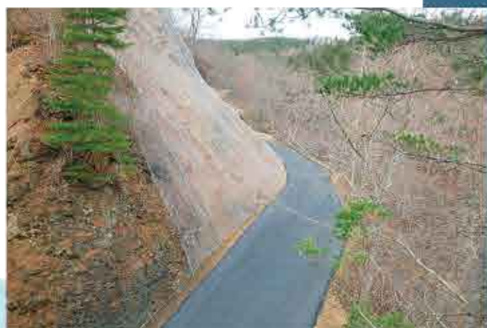
【林野庁宮城北部森林管理署】砥沢林道(林道専用道)新設改良 令和2年11月竣工
