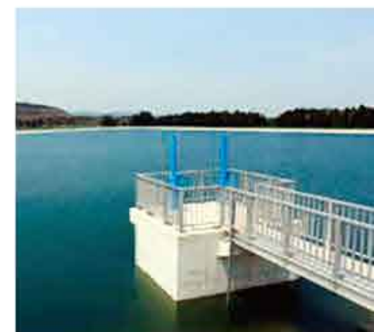
【宮城県】 用水対策地区(障害)061号柏木溜池(その2) 平成18年3月竣工
