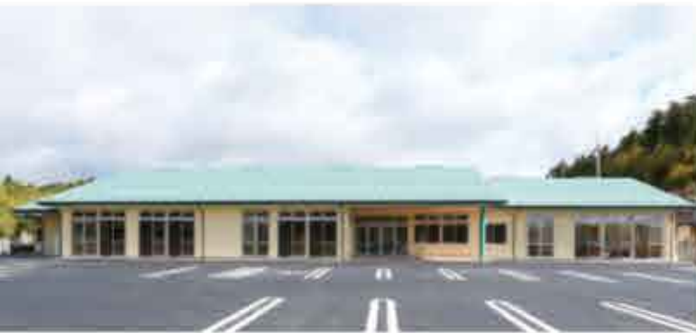
【社会福祉法人大崎市社会福祉協議会】 生活介護施設「元気」 平成28年3月竣工
