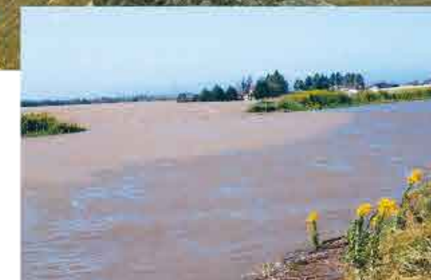
関東・東北豪雨渋井川氾濫
