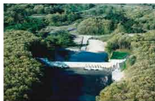
【宮城県】花川台七草台砂防ダム 平成14年5月竣工
