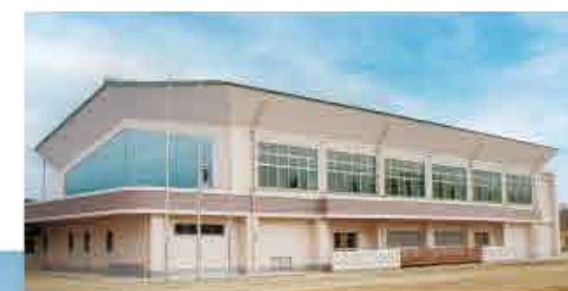
【宮城県大和町】 大和町宮床中学校屋内運動場 平成25年3月竣工
