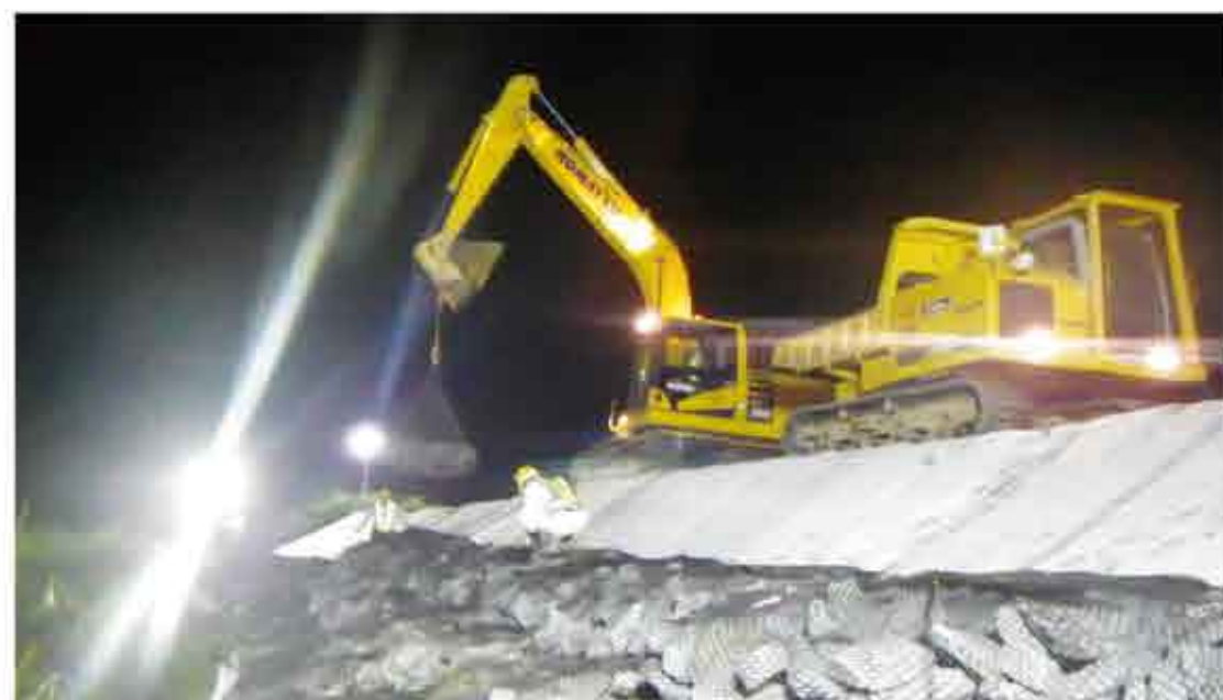
鳴瀬川水系渋井川緊急復旧工事
