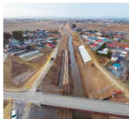
【宮城県北部土木事務所】 渋井川堤防補強 令和3年9月竣工
