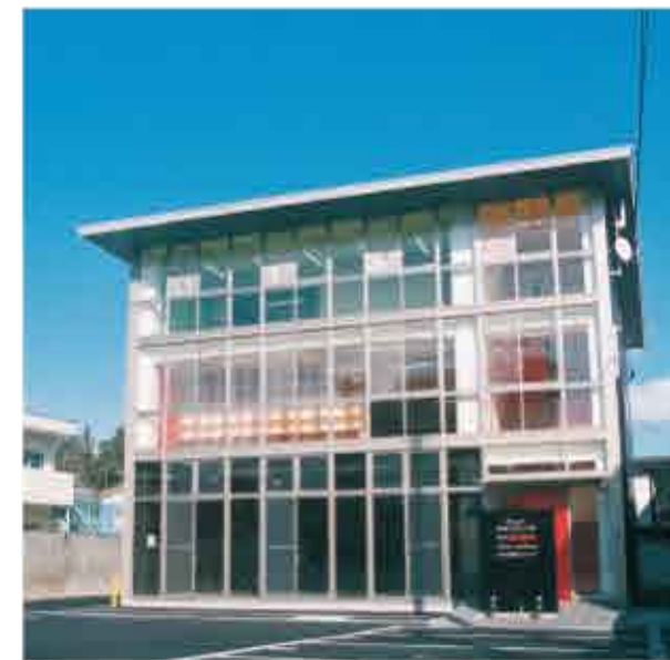
【(有)プランニング開】プランニング開オフィス 平成27年3月竣工
