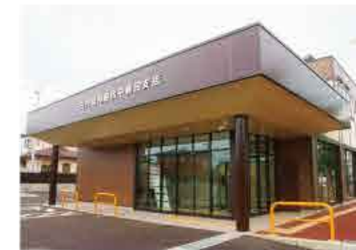
【古川信用組合】 古川信用組合中新田支店 令和4年7月竣工
