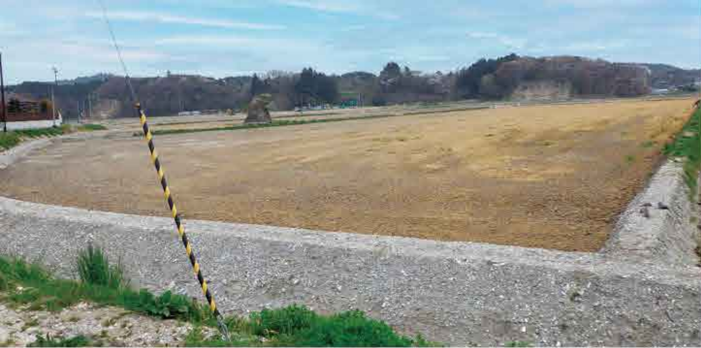
【宮城県】手樽地区(復興基盤)手樽5工区区画整理 令和元年5月竣工
