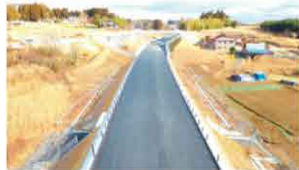
【国土交通省仙台河川国道事務所】 津谷長根地区道路改良 平成31年1月竣工
