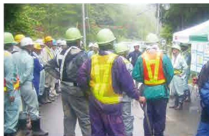
小川原地区緊急復旧工事・現場朝礼
