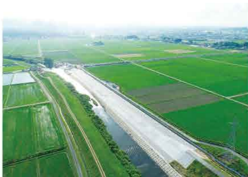
吉田川上流上舞野西地区河道掘削工事
