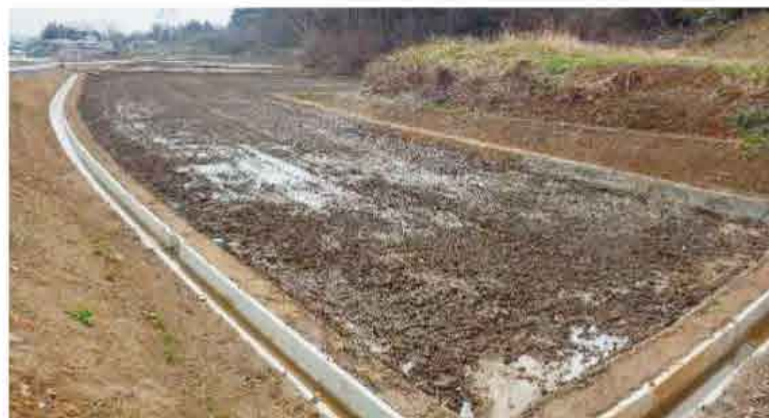
東日本大震災で被災の気仙沼地区最知工区農地復旧
