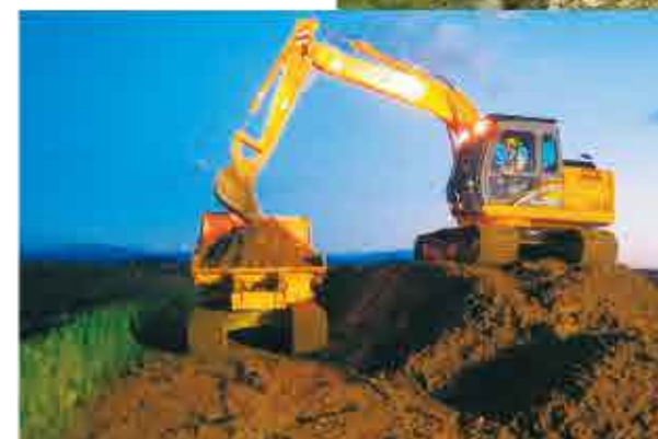
鳴瀬川水系渋井川緊急復旧工事
