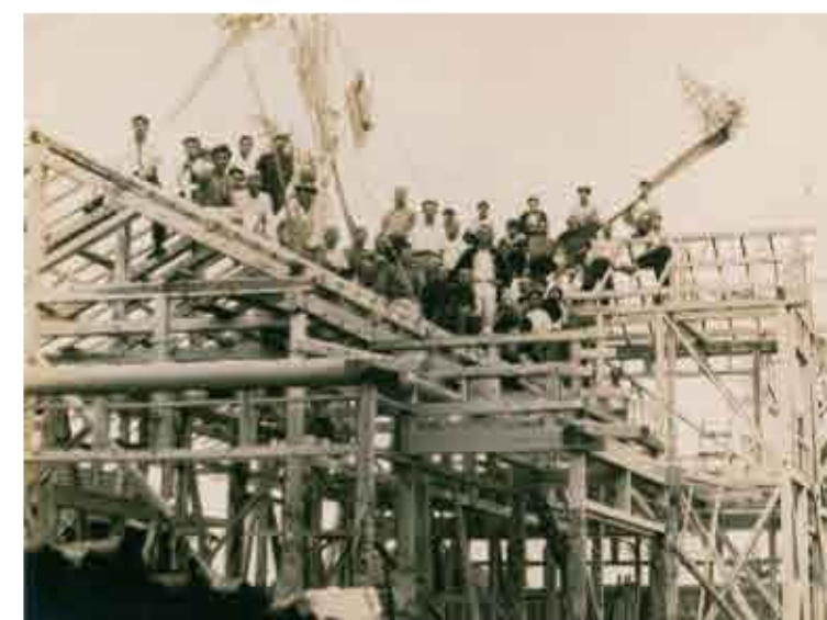
三軒橋浅勘酒造店の上棟式 昭和37年
